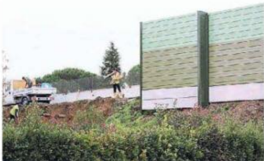
La messa in opera dei pannelli fonoassorbenti (Foto Nucci)
